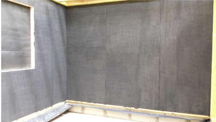
Les bandes alu entre les panneaux sont recouvertes de peinture et nous avons pu constater une continuité parfaite entre les panneaux de la maison. On a déjà pu ressentir une modification aux niveaux des hautes fréquences mesurées, mais cela passait bien entendu à travers les baies des fenêtres et des portes extérieures.
